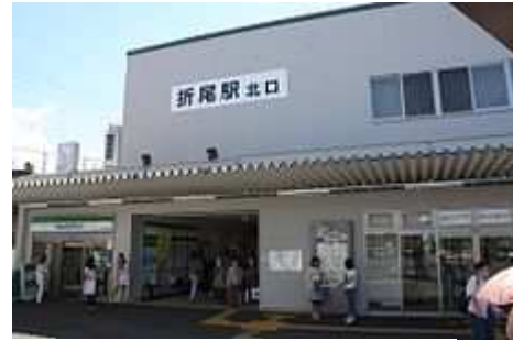
新設された北口仮駅舎
